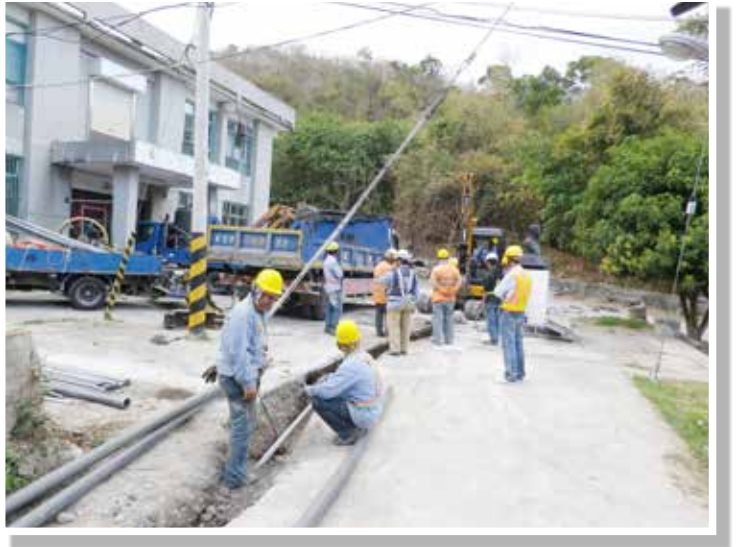
▲維生管線電纜地下化工程施工實況。
