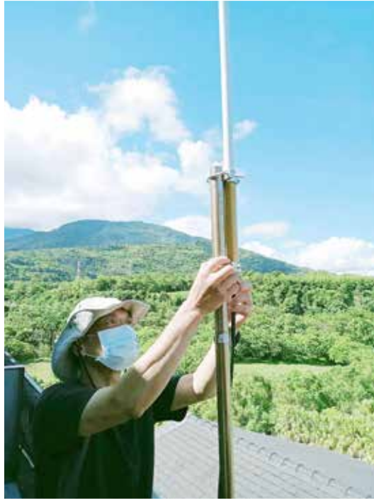
◀ 架設UTM系統實況。
