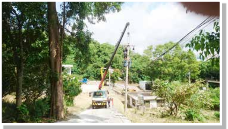
▲電力及電信高架纜線、水泥桿移除。
